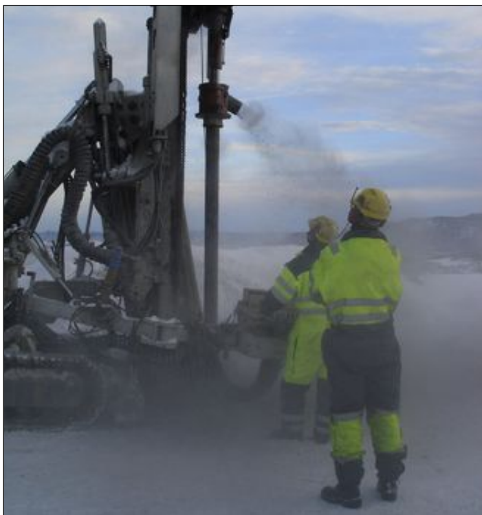
DYPT: I gjennomsnitt bores det nå hele 211 meter ned når det lages energibrønner til de større grunnvarmeanleggene, ifølge NGU.
