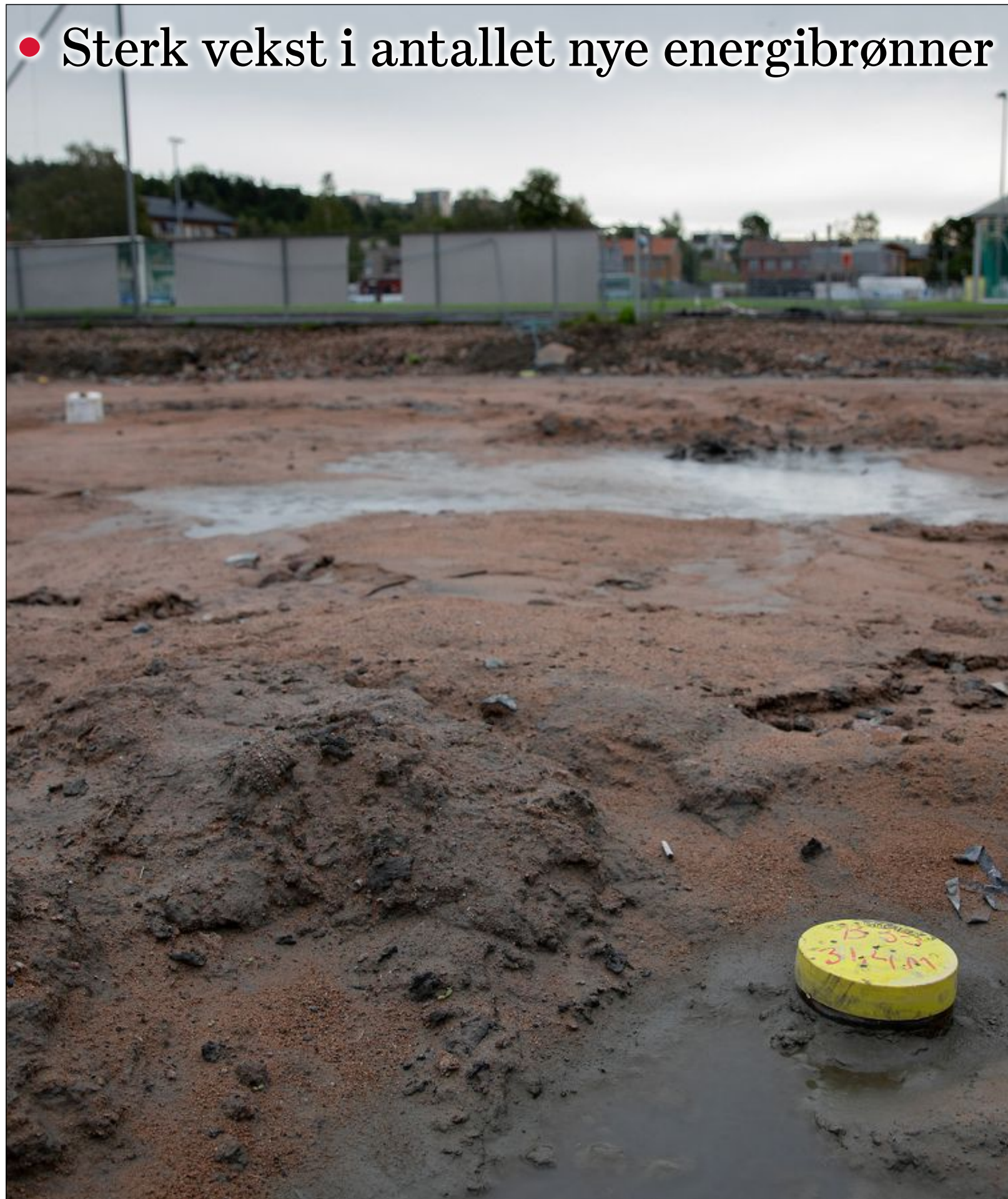
LITE PRANGENDE: – De synes ikke, sier grunnvarmeekspert Randi Kalskin Ramstad om hvordan grunnvarmeanleggene framstår. Slik ser det ut på ferdigstilt boringen av energibrønnene som idrettslaget snart tar i bruk.
