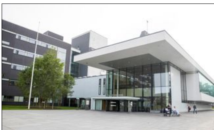
114 ENERGIBRØNNER: Ved Akershus universitetssykehus i Lørenskog har Enova støttet boring av hele 114 energibrønner.
